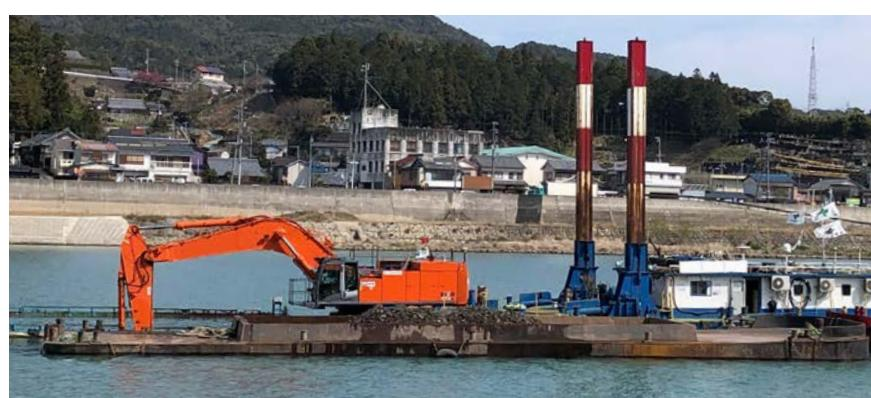
取得した点群データは、ICT 河川浚渫工、河床掘削工の施工履歴データとして活用できます。
